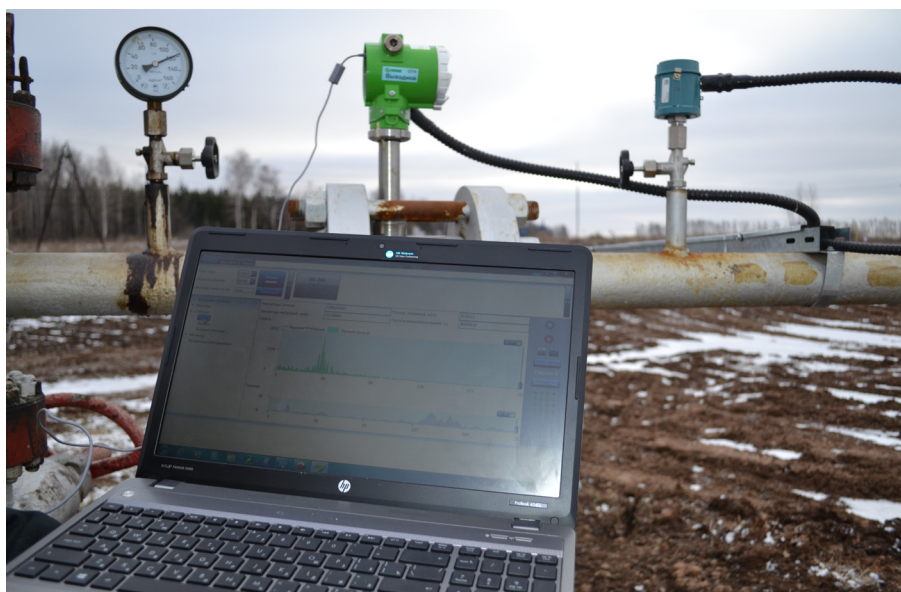
Рис. 2. Настройка расходомера с помощью программы «ЭМИС-ИНТЕГРАТОР» для учета закачиваемой в скважину подтоварной воды (технологический процесс поддержания пластового давления)
